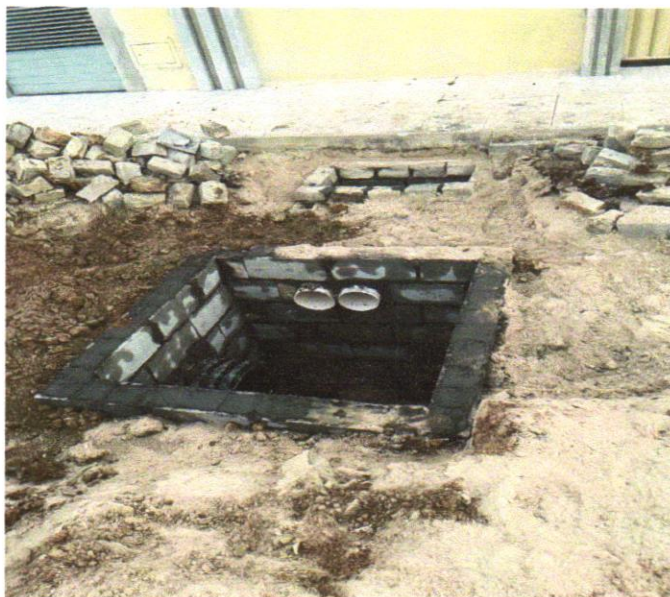
Foto 10 - ALVENARIA DE BLOCOS DE CONCRETO ESTRUTURAL 14X19X39 CM, (ESPESSURA 14 CM) FBK = 14,0 MPA, PARA PAREDES COM ÁREA LÍQUIDA MENOR QUE 6M 2 , SEM VÃOS, UTILIZANDO PALHETA. AF_12/2014
