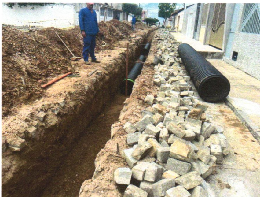
Foto 14 - FORNECIMENTO E ASSENTAMENTO DE TUBO CORRUGADO PAREDE DUPLA PEAD, D = 600 MM (24"), PARA SISTEMAS DRENAGEM, TIGRE - ADS N-12
